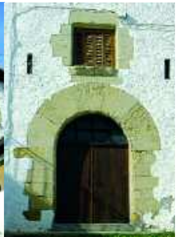
Darieta baserria. Xehetasuna.
